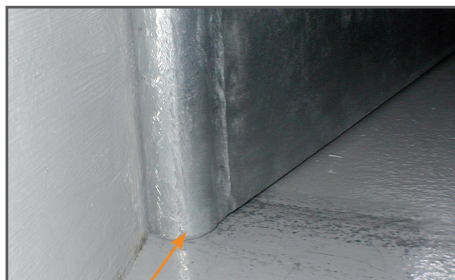
боковые скребки Внимание: острия края! (-> закруглить!)
