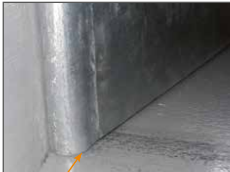
zij mestkleppen let op: scherpe kanten (-> afronden)
