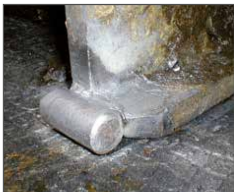
glijvoet met ronde staaf en breed steunoppervlak
