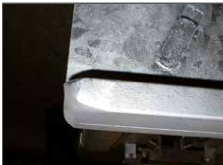
de steunvlakken van de glijvoet zijn afgerond
